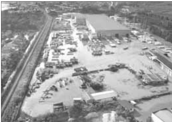
I danni provocati dall'alluvione del 3 luglio 2006 in questa foto aerea
