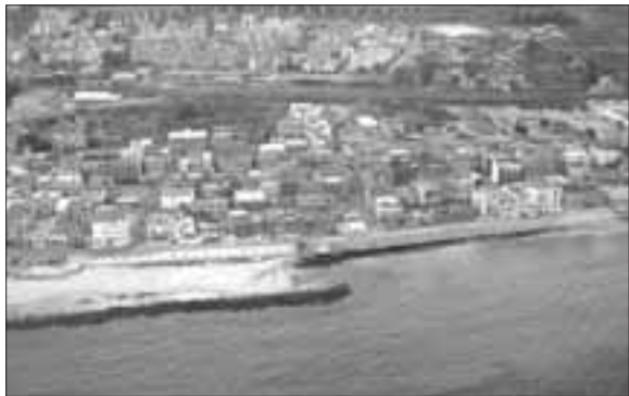
Il lungo litorale del rione Pennello a Vibo Marina. A lato i danni provocati dall'erosione costiera
