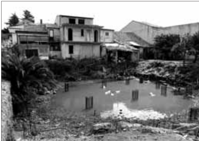
L'enorme buca situata in via XXV aprile, davanti all'ospedale: esempio di autentico degrado urbano
